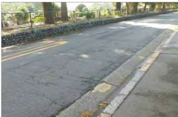
図 3-2-4 MCI=3 ひび割れが面状にひろがり、わだちが顕著
