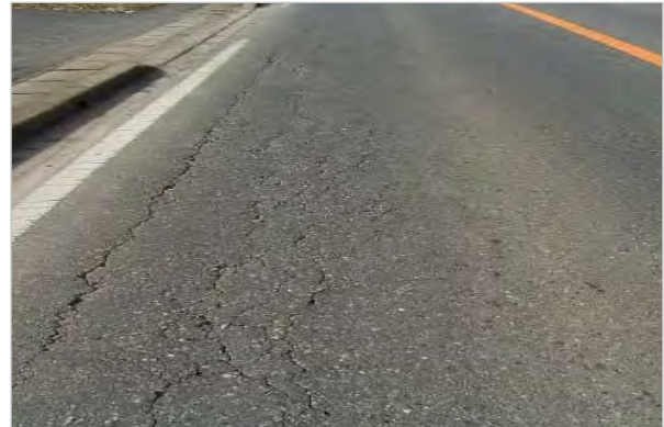
図 3-2-3 MCI=3.5～4 ひび割れが複数ある程度
