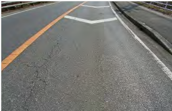
図 3-2-2 MCI=5 ひび割れが見える程度
