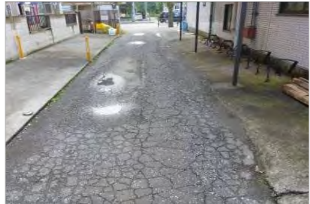
図 3-2-5 MCI=2 ひび割れが全面にひろがり、わだち掘れが顕著
