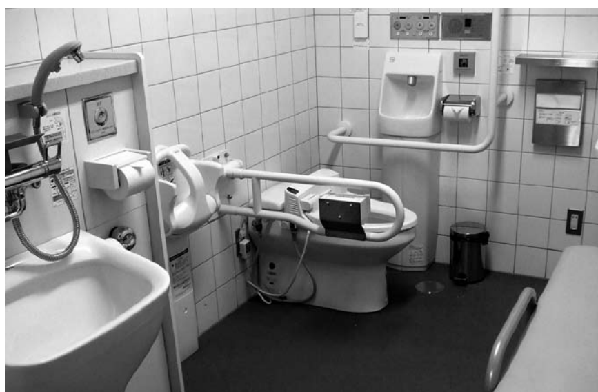
だれでもトイレ（オストメイト対応設備、ベビーチェア、多目的シートが設置されている）
