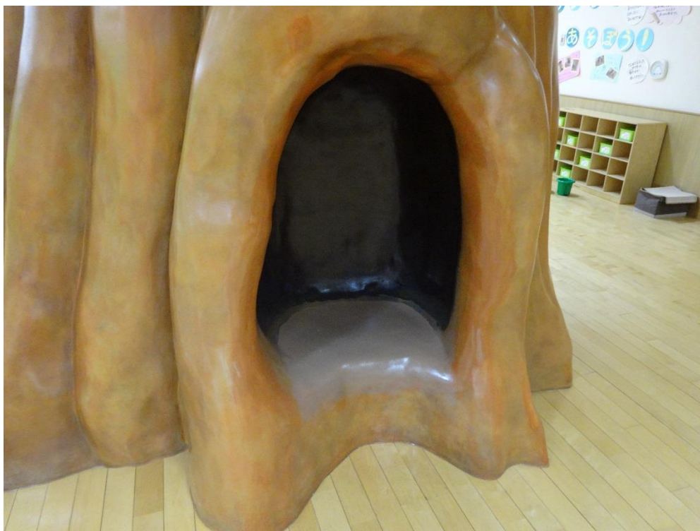
(2) 西側交流ひろば内からくり時計の腰かけ部分の塗装
