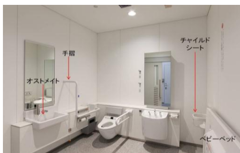
多目的トイレ(甲府市庁舎)
