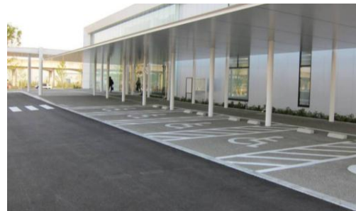
車いす駐車場(つくば市庁舎)
