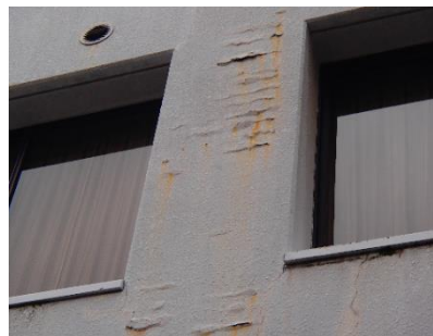
鉄筋の腐食による影響
