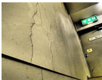
壁面のひび割れ
