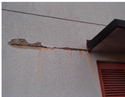
鉄筋の腐食による影響
