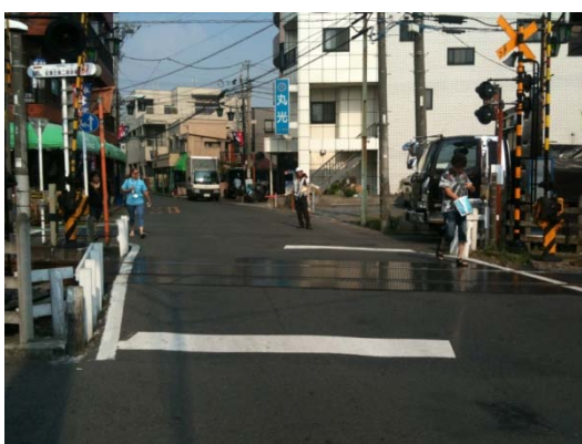
多磨駅踏切 車道幅員5 m 両側に路肩表示、路側帯なし
