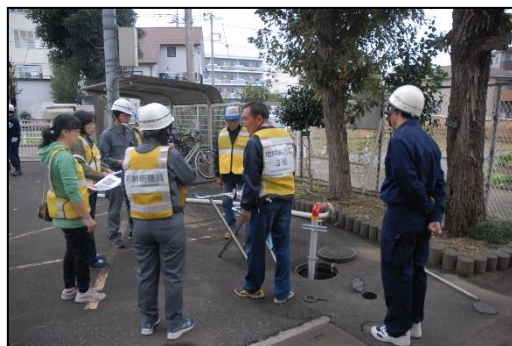
応急給水栓の確保
