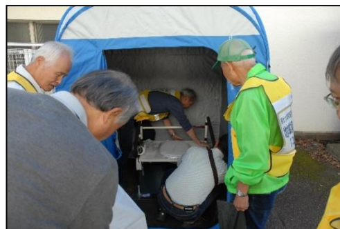
仮設トイレの設置
