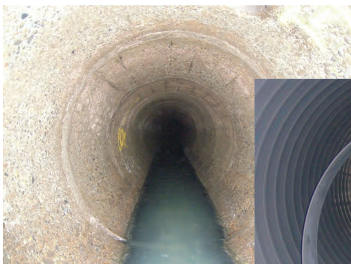
老朽化の進んだ管きよ
