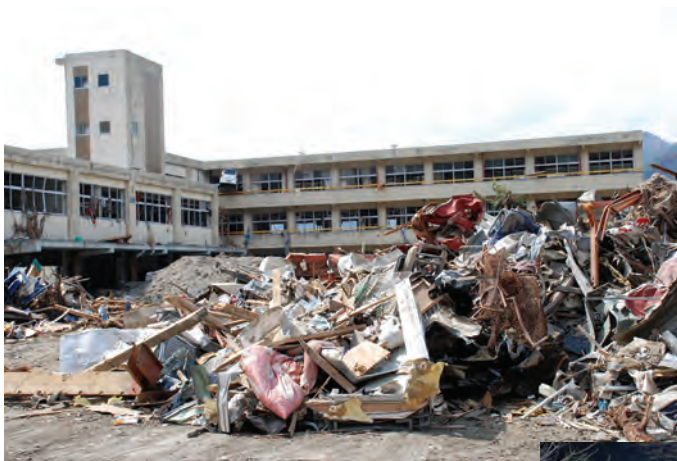
東日本大震災での被害状況
