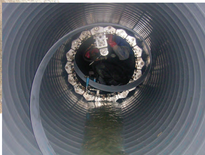
更生工事中の下水道管
