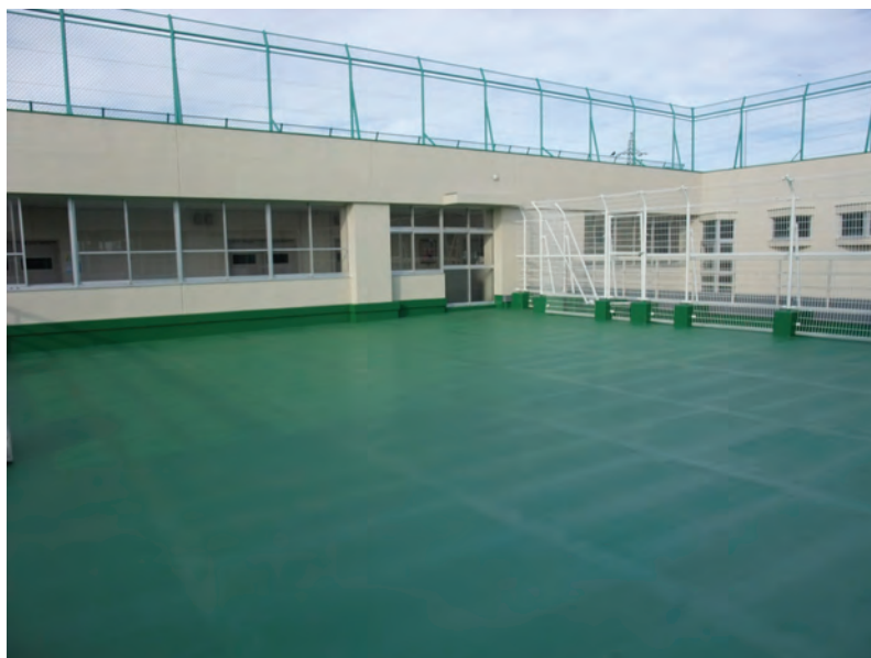
第九中学校屋上防水工事後
