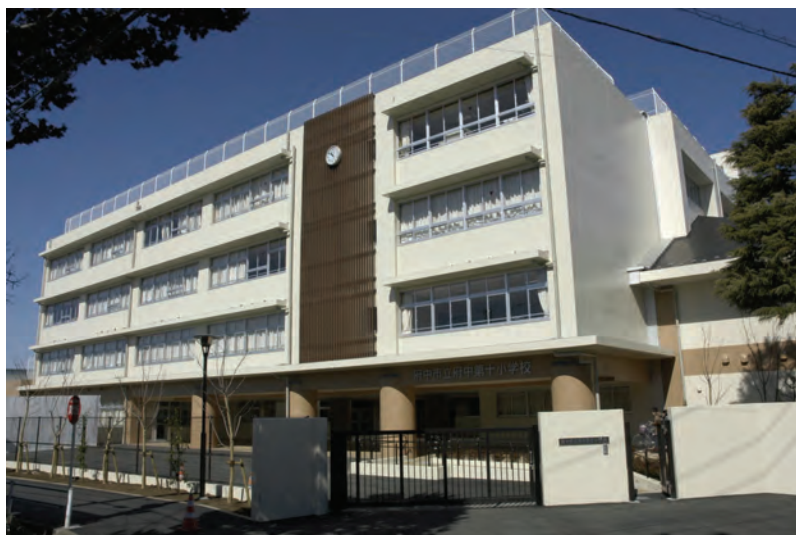
第十小学校改築工事後
