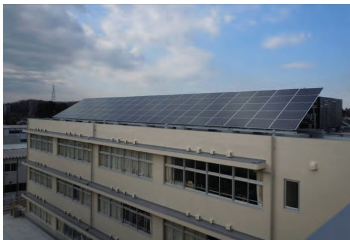
第十小学校に設置した太陽光発電ソーラーパネル
