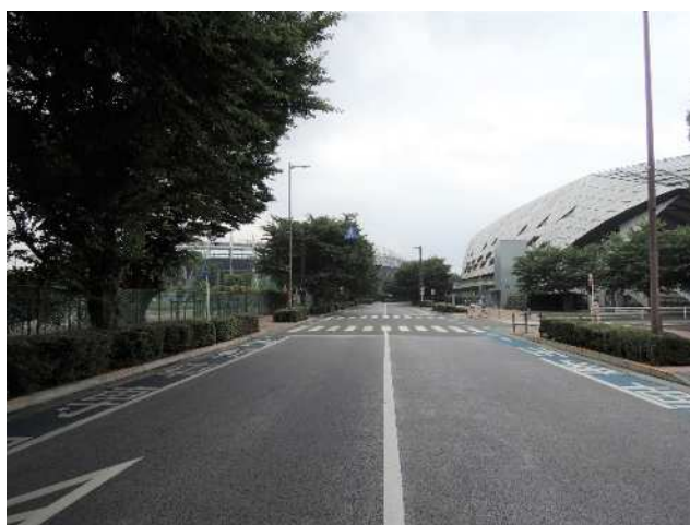
図 4-9 無電柱化されたスタジアム通り
