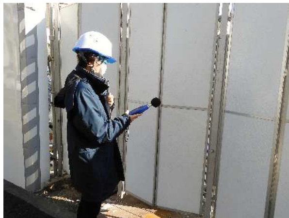
図 4.20 騒音調査の様子
