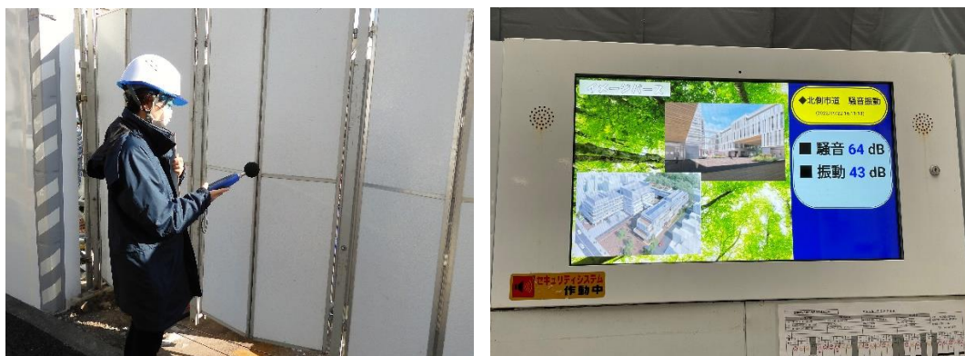
図 4.20 騒音調査の様子（左）と建設現場の騒音・振動レベルの電光掲示板（右）
