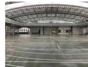
屋上グラウンド
