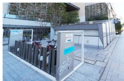
公開空地へのサイクルポートの 設置例（神奈川県横浜市）
