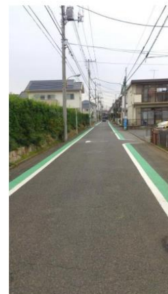
区画線&路側帯カラー舗装
