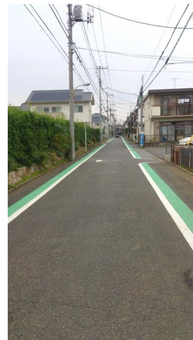
区画線 & 路側帯カラー舗装
