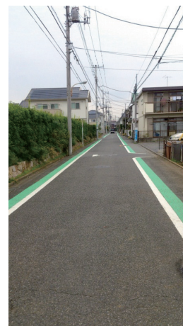
区画線及び路側帯カラー舗装
