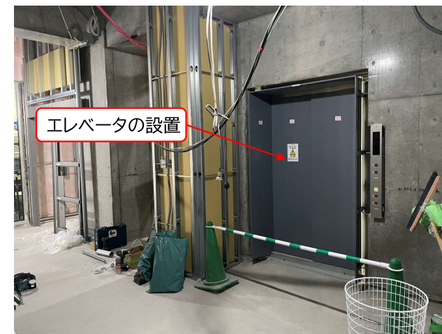
「エレベータホール」の状況写真
