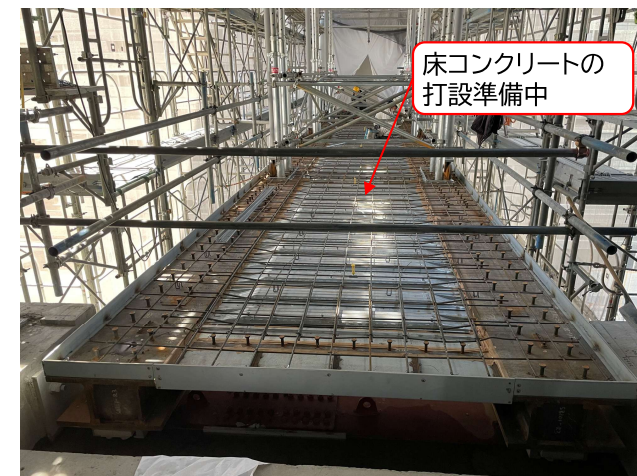
「ブリッジ」の状況写真
