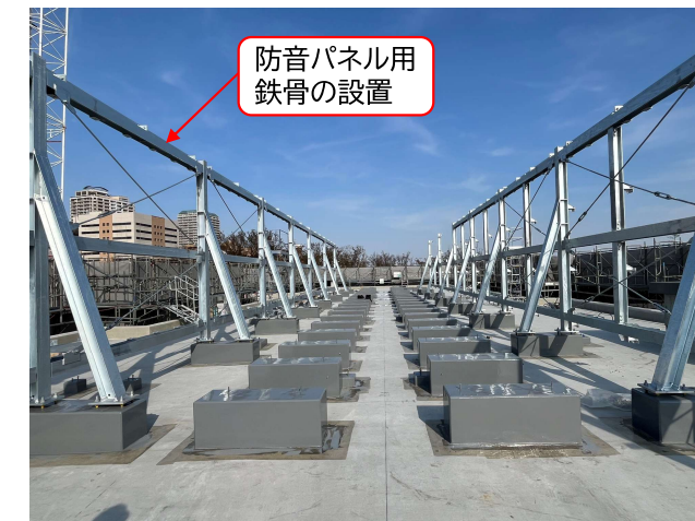
「室外機置場」の状況写真
