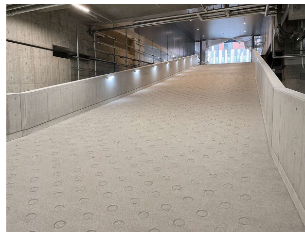
「出入口スロープ」の状況写真
