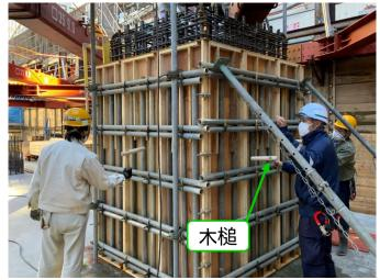
・柱の打設は、柱の上部からコンクリー トを流し込みます。その際に、型枠の 内側では振動機を用いてコンクリート の締固めを行い、外側では木槌で叩い て型枠内に満遍なくコンクリートが行 き渡るようにしています。
