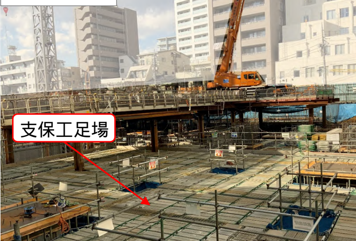
足場上の様子
