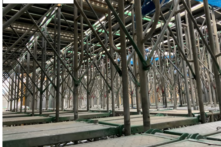
足場内の様子
