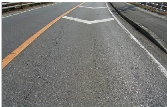
図3-2-3-6 MCI値=5 ひび割れが見える程度
