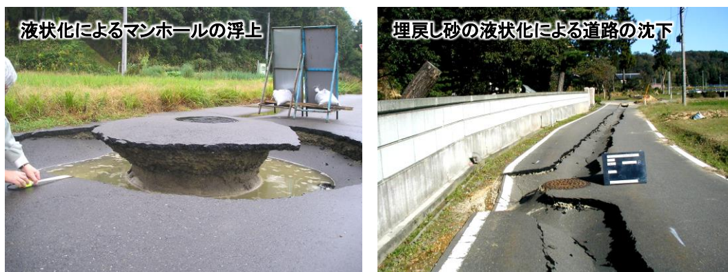
図3-2-15-5 中越地震における液状化による被害例
