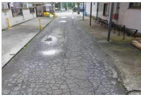
図3-2-3-9 MCI値=2 ひび割れが全面にひろがり、わだち掘れが顕著
