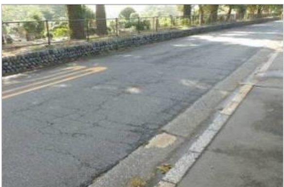
図3-2-3-8 MCI値=3 ひび割れが面状にひろがり、わだち掘れが顕著
