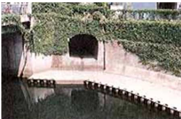
図1-3 雨水吐口からの未処理放流水の流出状況(他都市の例)
