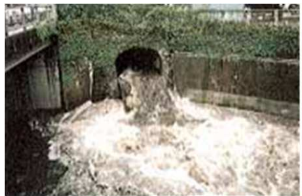
図1-3 雨水吐口からの未処理放流水の流出状況(他都市の例)
