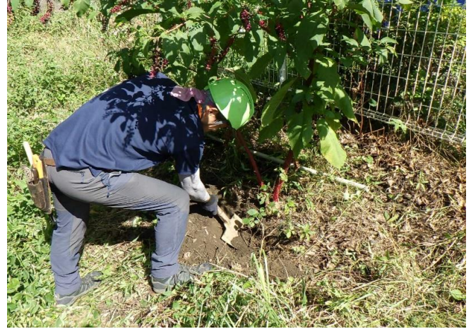
根茎が深い為、スコップでの掘削除去
