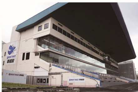
※現在は施設改修中
