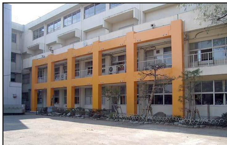
若松小学校 耐震工事
