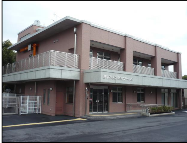
水防・防災ステーション
