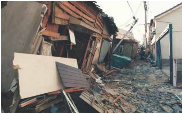
(写真提供:神戸市東灘区国道2号小路付近)
