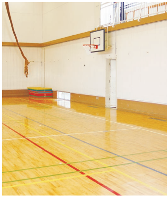
▲床の修繕を行った小学校の体育館
