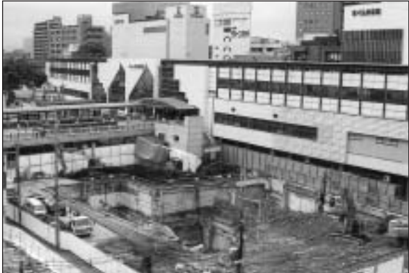
▲建物の解体が進む第三地区
