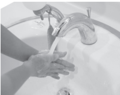
▲自動水栓化された水道蛇口
