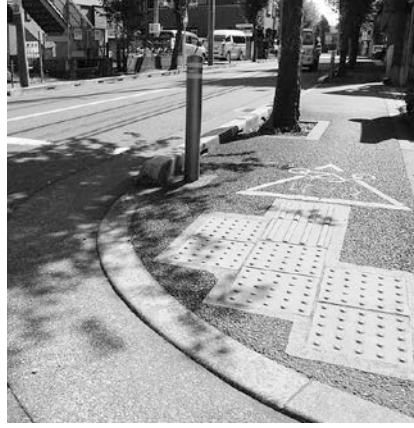
▲バリアフリー化された道路
