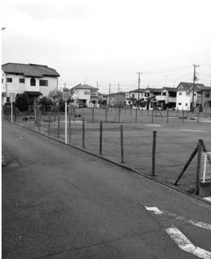
▲東八道路の整備が進む西原町周辺
