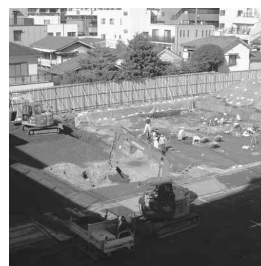
▲市庁舎建設工事の様子
