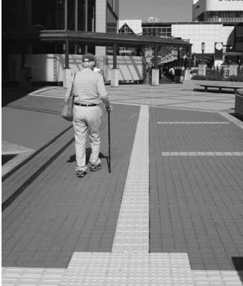
▲点字ブロック
