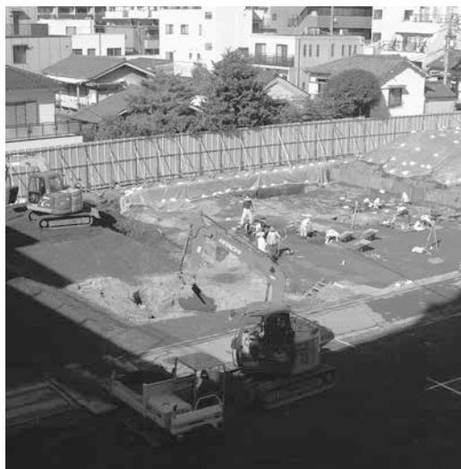
▲市庁舎建設工事の様子
