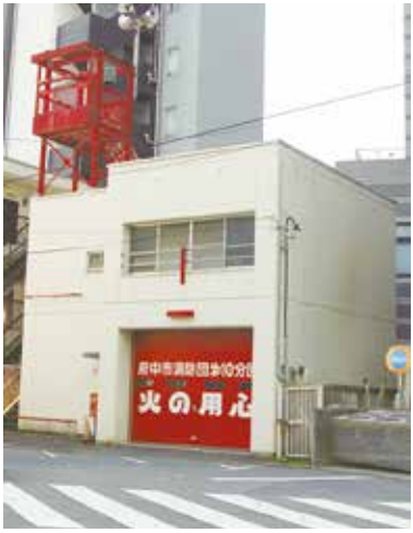
▲地域防災センター
