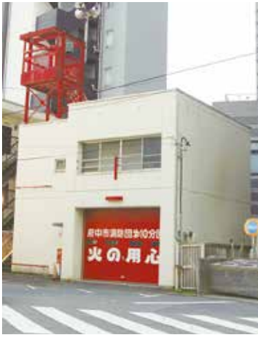
▲地域防災センター
