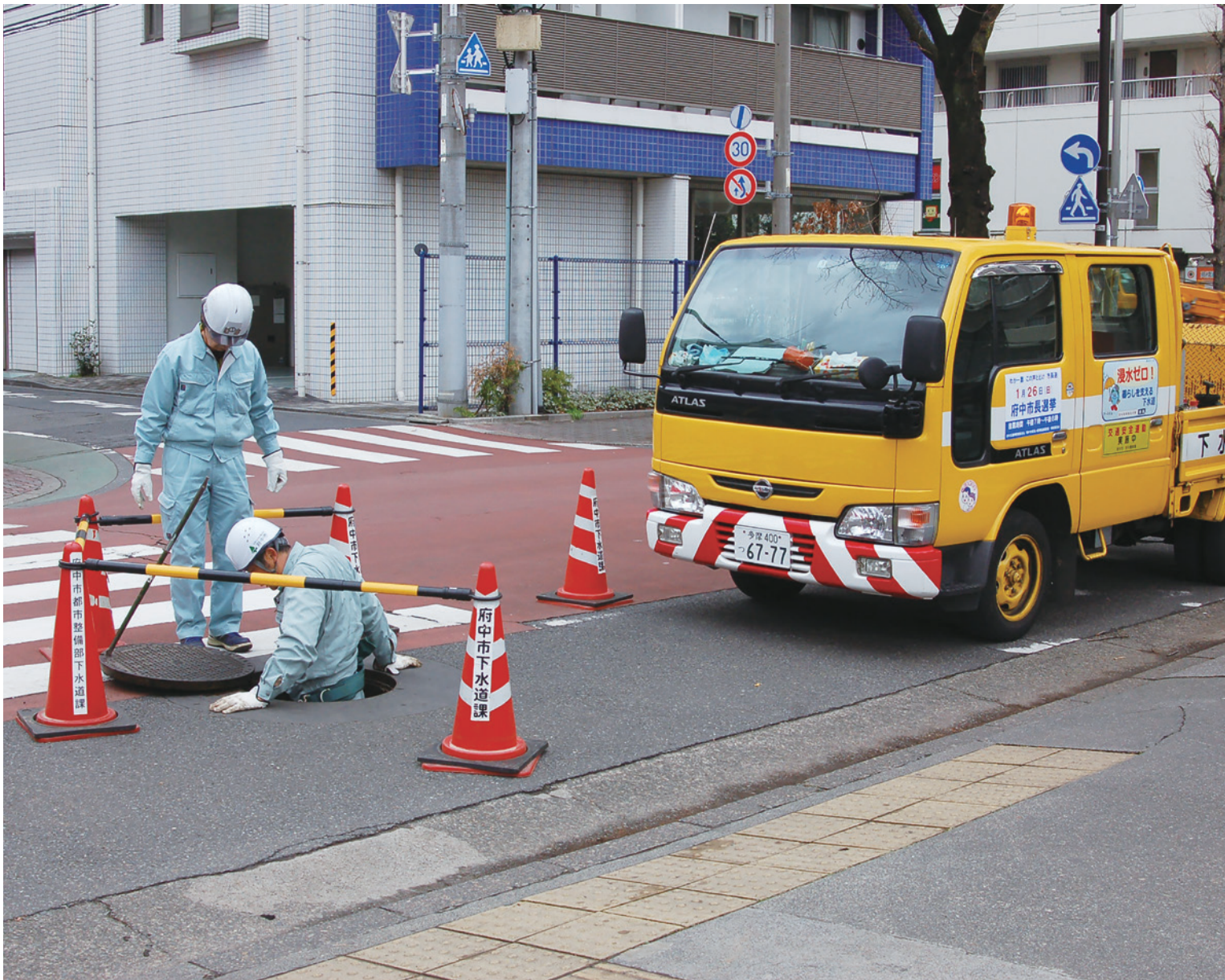
▲下水道課の職員によるマンホールの点検作業
