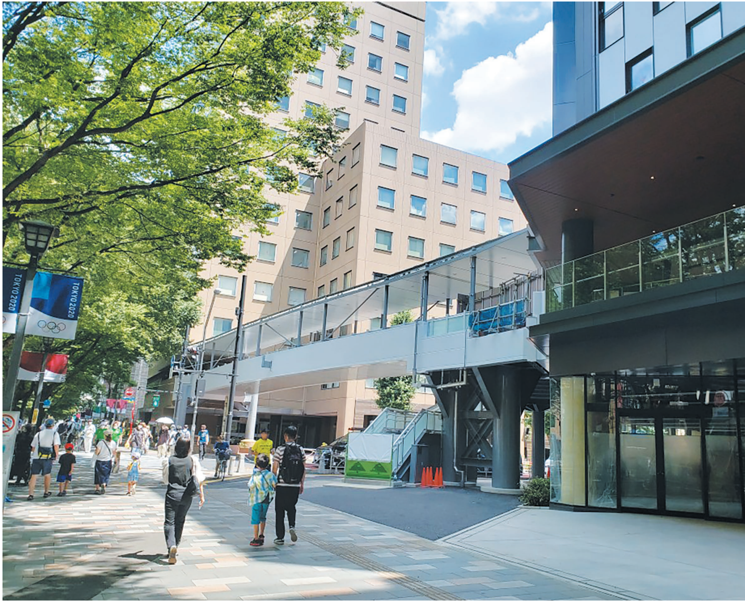
▲令和3年7月27日に開通した府中スカイナード
