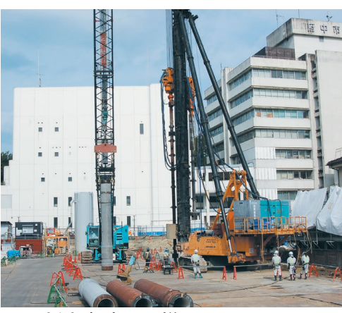
▲新庁舎建設の様子
