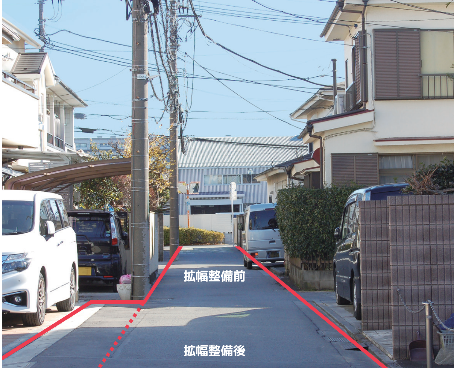
▲拡幅整備が行われた狭あい道路
