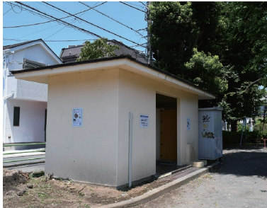
▲改修前の公園トイレ
