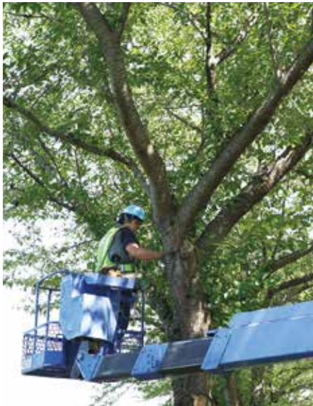
▼樹木の点検・確認作業の様子
