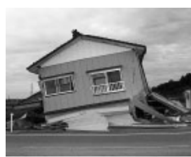
▲新潟県中越地震で倒壊した家屋
