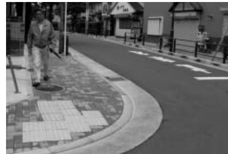
▲歩道のバリアフリー化を進めます
