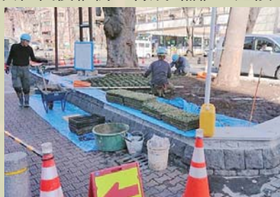
◀けやき並木通りで行われている石積改良工事
