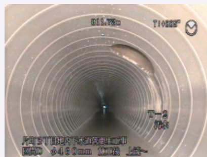
老朽化対策工事施工後
