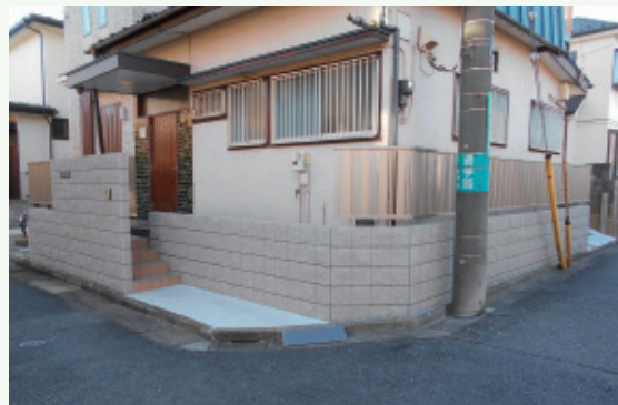
ブロック塀改修(施工後)
