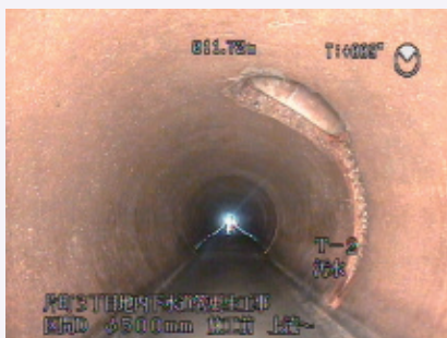
老朽化対策工事施工前
