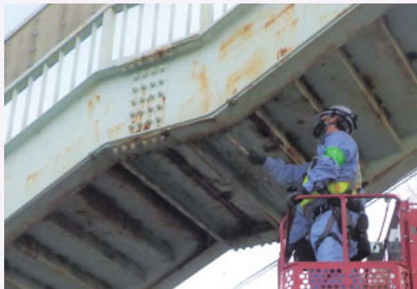
構造物の点検
