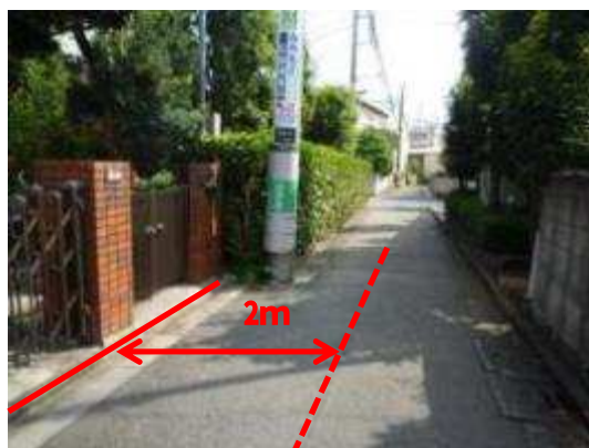
狭あい道路を拡幅整備した箇所
