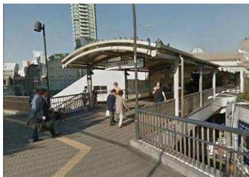
駅改札から繋がる跨線橋（デッキ）
