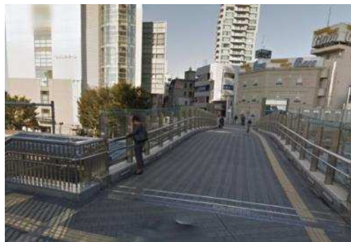
線路をまたぐ跨線橋（デッキ）
