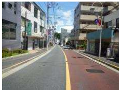
歩道の幅員が狭い状況
