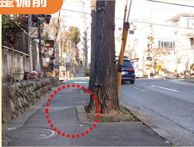
根上がりがある歩道
