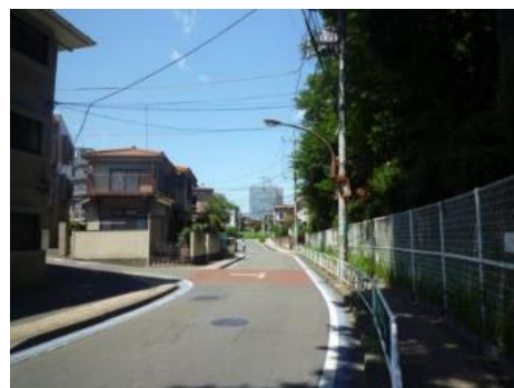
歩道の幅員が狭く、車道に向かって傾斜している
