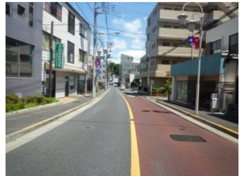
歩道の幅員が狭い状況
