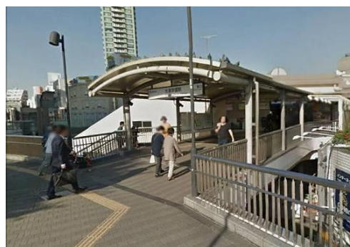
駅改札から繋がる跨線橋（デッキ）
