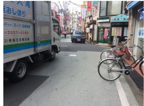
車がすれ違う際、歩行者の逃げ場がない状況
