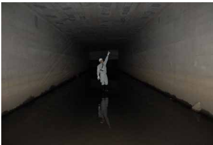
図 4-7 都市下水路の内部の様子
