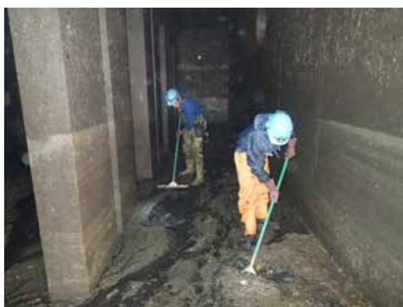
図 5-4 貯留施設の維持管理の様子
