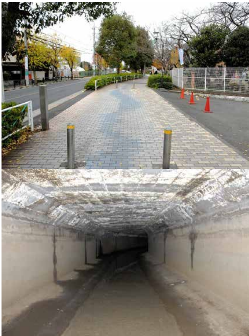
図 2-8 第二都市下水路 （上：都市下水路上部（歩道） 下：都市下水路内部）
