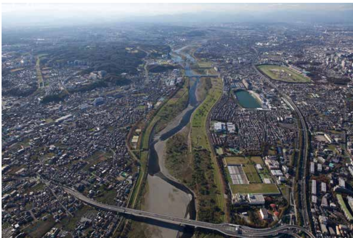
北多摩一号水再生センター
