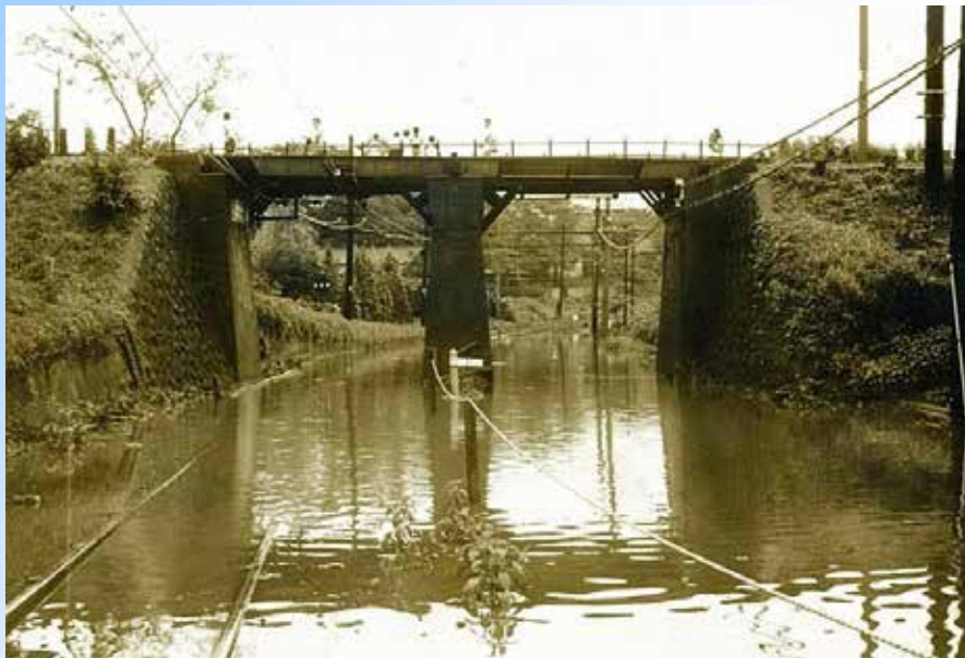
南武線の線路が冠水した様子(昭和 30 年代後半)
