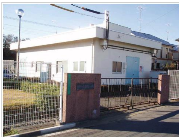
図 3-2-14-4 押立ポンプ場 外観
